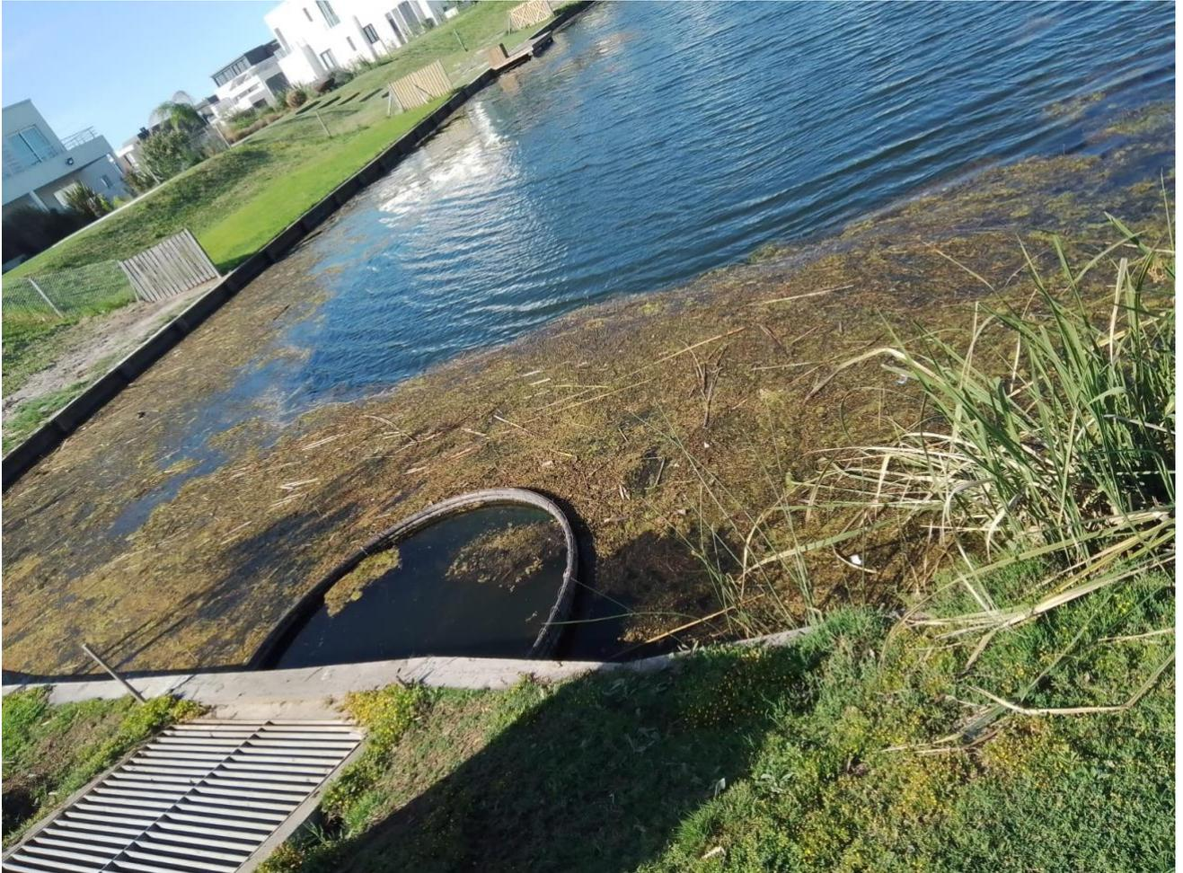
Imagen N° 5. Vista de las áreas de bombas de recirculación que deben ser despejados de vegetación arraigada o flotante.
